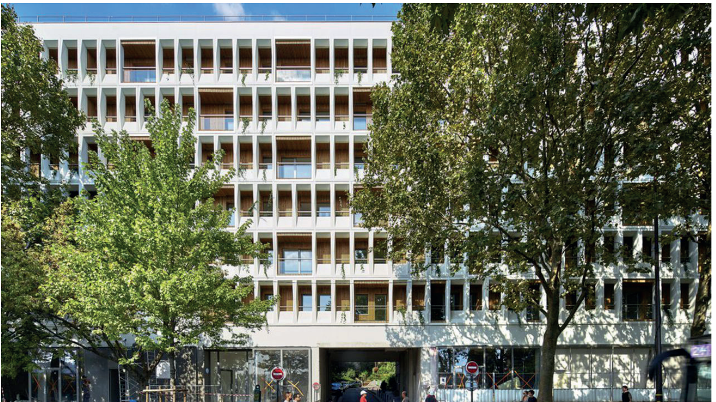
Fin 2016, l'agence d'architecture Moatti-Rivière a livré au bailleur social 3F un immeuble de bureaux entièrement réhabilité. La façade, donnant sur l'autoroute, a été revisitée pour amortir le bruit et donner au bâtiment une nouvelle physionomie. (© Michel Denancé)
